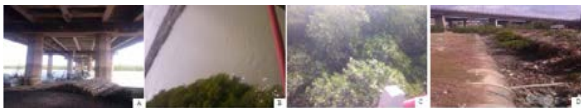
Figura 1. Principais fatores que influenciam surgimento de patologias em concreto. Fatores: (a) Físicos (umedecimento e secagem); (b) Químicos (íons de cloreto); (c) e (d) Biológicos (microorganismo entre outros).
