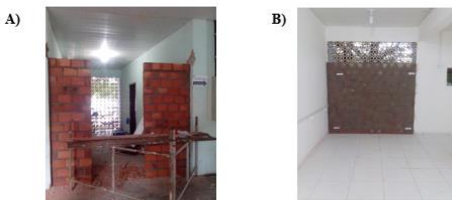
Figura 2: A) Construção da parede 5. B) Isolando a parede 2.
