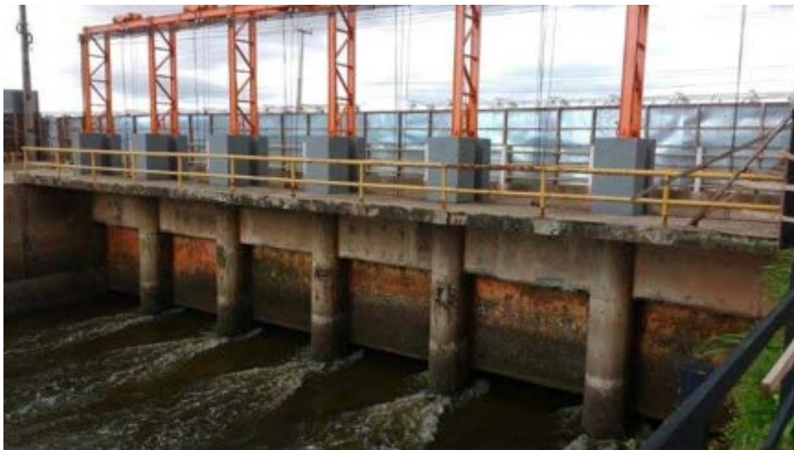
Figura 1. (Stops-legs em funcionamento na barragem do Bacanga).
