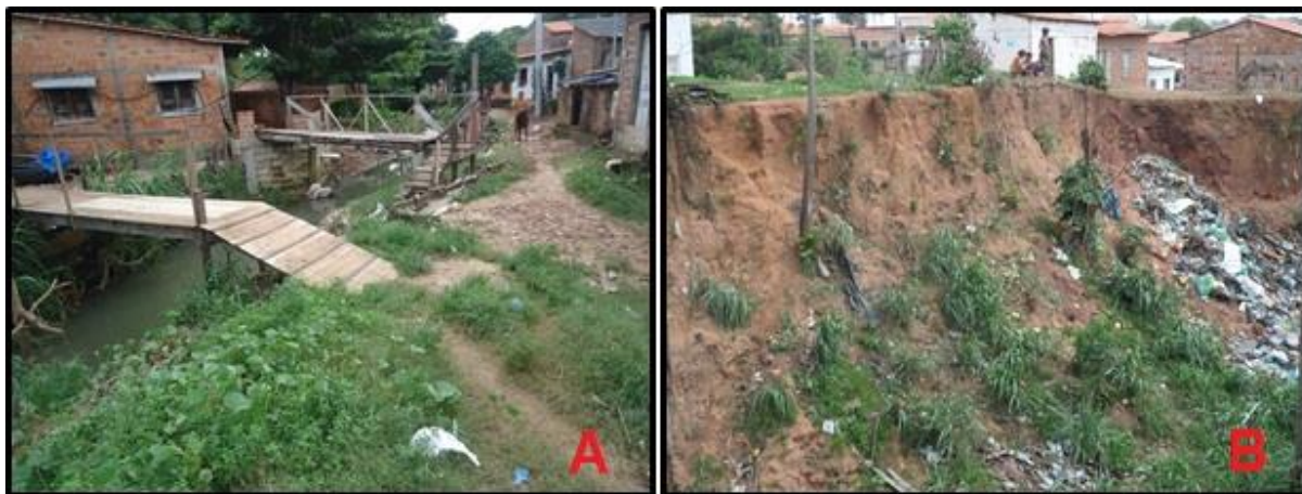
Figura 2. Ocupação desordenada nas morfologias: A – Ocupação na planície fluvial (Área de Preservação Permanente - APP); B – Ocupação da cabeceira da voçoroca e depósito de resíduos sólidos na mesma.
