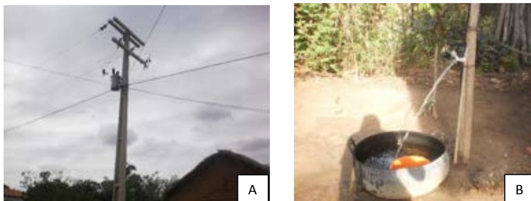
Figura 2. (A) Energia Elétrica Trifásica, (B) água encanada.
