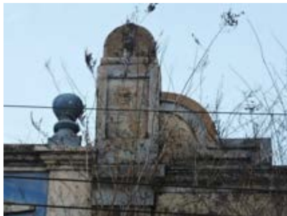
Figura 4. Detalhe em Platibanda, São Luís – MA.
