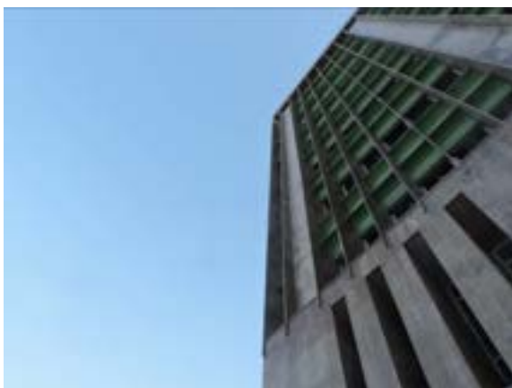
Figura 5. Detalhe dos pilares inclinados, Ministério da Fazenda, São Luís - MA.
