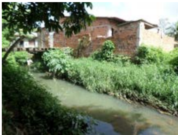
Figura 2. Residência em área de risco no Bairro Pirapora.
