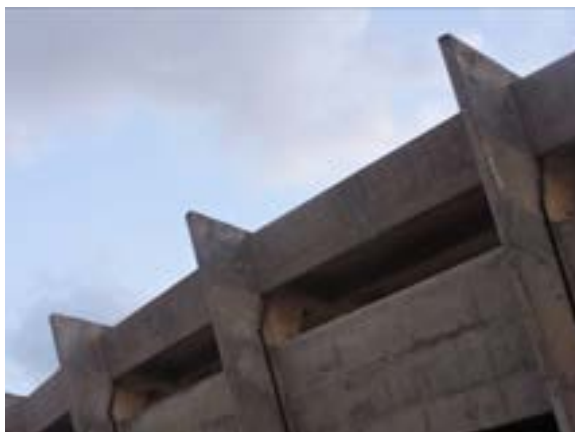
Figura 6. Detalhe dos pilares inclinados, Estádio Castelão, São Luís - MA.
