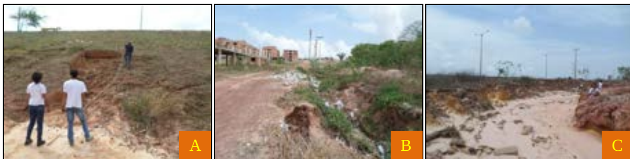
Figura 3. Voçoroca Castelão (A), Voçoroca Bequimão (B), Voçoroca Sítio Santa Eulália (C).
