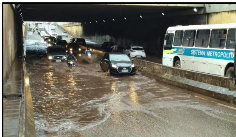
Figura 03: Túnel na Cohab com congestionamento e alagamento após a chuva.
