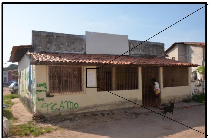
Figura 4: Fachada da associação e ampliação do cronograma de atividades na fachada
