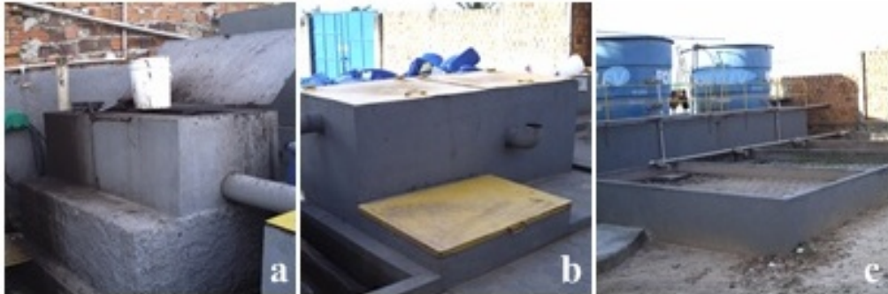
Figura 3: Estação de tratamento de efluentes químicos: a) tanque de lodo, b) tanque de decantação, c) tanque de derrames emergenciais.
