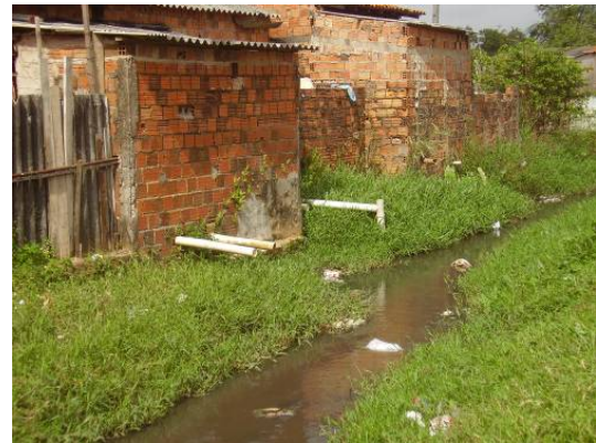
Figura 5: Vista de tubos de esgoto e da ocupação nas margens do canal
